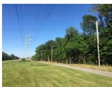
Emprise de transport : après les travaux
