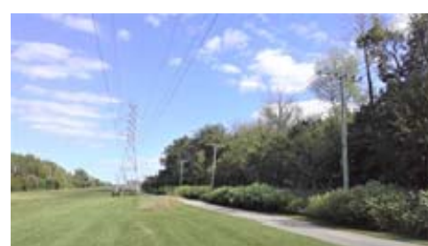
Emprise de transport : un an après les travaux alors que la végétation reprend ses droits
